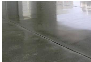
Juntas de pavimentos interiores transitáveis
